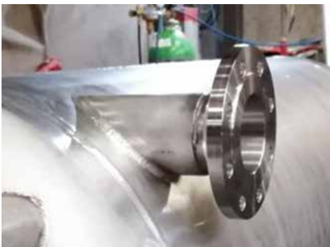
Abb. 6: Stutzeneinschweissung in Behälter
